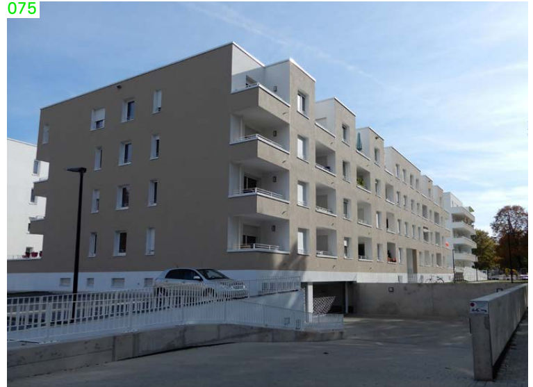
K Lahr, Sanierung Wohngebiet Kanadaring (→ 20): 268 Wohnungen wurden bereits umfassend modernisiert
