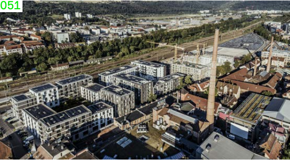
H Esslingen am Neckar, Neue Weststadt Klimaquartier (→ 9): Durch Integration innovativer Technologie nahezu klimaneutral
