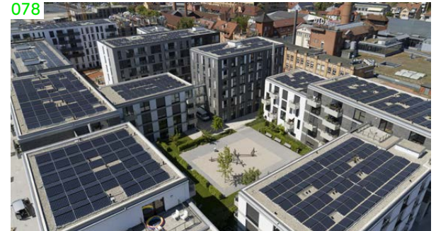
K Esslingen am Neckar, Neue Weststadt Klimaquartier (→ 9): Klimaneutralität u. a. durch Vollsolarisierung der Dachflächen
