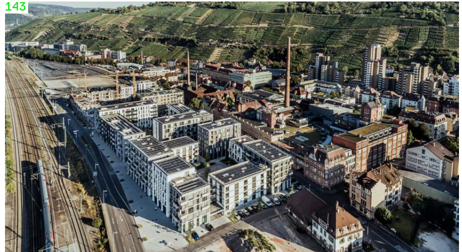
T Esslingen, Neue Weststadt Klimaquartier (→ 9): innovative Stadtentwicklung auf dem ehemaligen Güterbahnhofsareal
