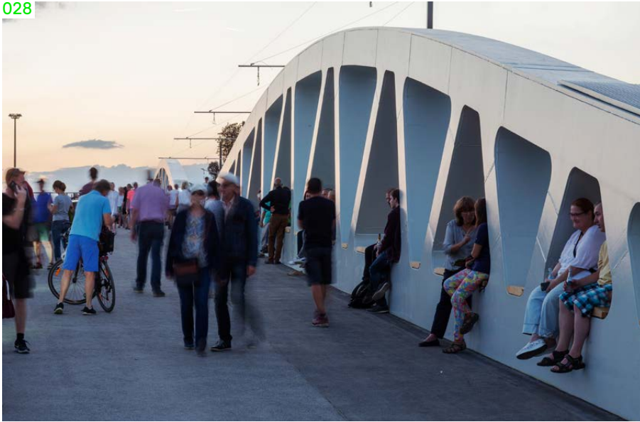
E Ulm, Kienlesbergbrücke (→ 34): Wichtige Wegeverbindung mit hoher Aufenthaltsqualität
