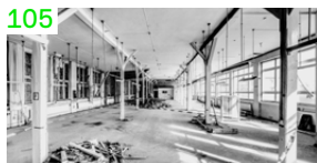
105 Gomaringen, Umbau ehem. Kindlersche Fabrik (→ 11): Die Niederwarenfabrik vor der Sanierung
