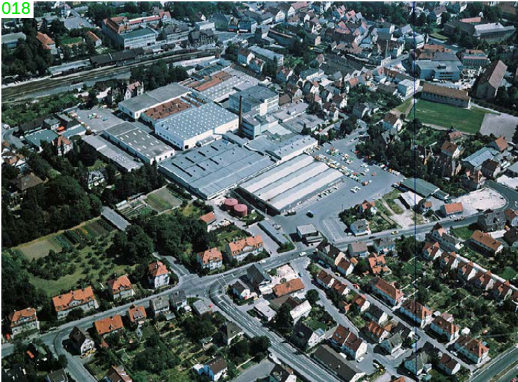
C Kirchheim u. T., Steingauquartier (→ 17): Ausgangssituation – Maschinenfabrik (1975)
