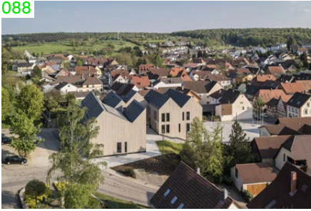
M Walzbachtal, Neubau Rathaus Wössingen mit Rathausplatz (→ 36): Der Neubau stärkt die Ortsmitte
