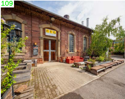
P Karlsruhe, Alter Schlachthof (→ 15): Ehemalige Kaldaunenwäsche – heute Büros
